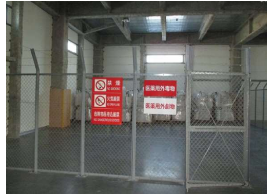
東京化学品センター 毒物劇物貯蔵施設
