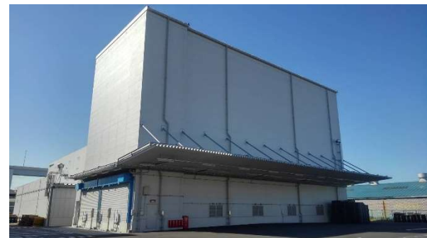
危険物屋内貯蔵所②（立体自動倉庫）
