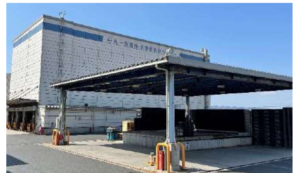
弊社水島港物流センター 危険物屋内貯蔵所(自動立体倉庫)=奥=と 危険物一般取扱所=手前=
