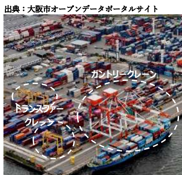
ガントリークレーンとトランスファークレーン (大阪港咲洲 CT)
