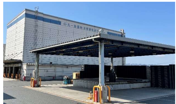
弊社水島港物流センター 危険物屋内貯蔵所(自動立体倉庫)=奥=と 危険物一般取扱所=手前=
