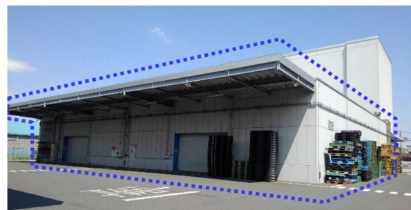
危険物屋内貯蔵所①（平屋建）
