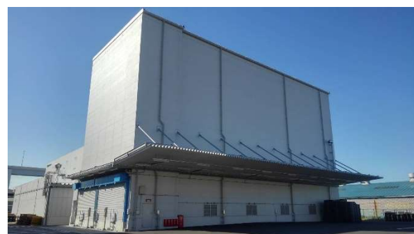
危険物屋内貯蔵所②（立体自動倉庫）
