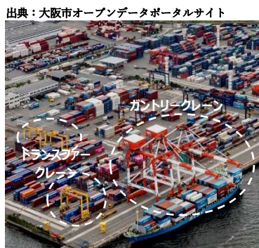
ガントリークレーンとトランスファークレーン (大阪港咲洲 CT)
